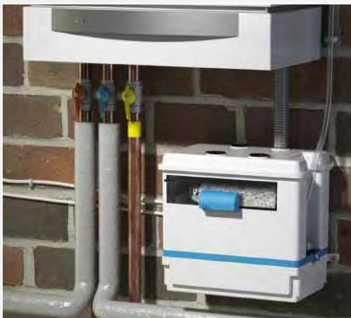
Refoulements vertical et horizontal : ↑ 4,5 m → 50 m
