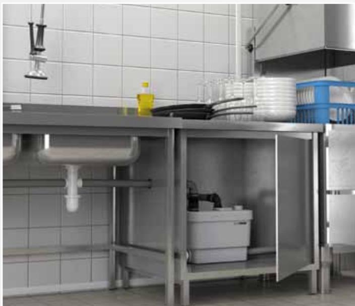
Refoulements vertical et horizontal : ↑ 7 m → 70 m
