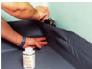
05. Dans les angles, replier soigneusement le surplus de la feuille Isotanche avec un pli mouchoir. Coller à l'aide de la colle spéciale pour remontées Isotanche. Astuce : pour éviter tout effet de surépaisseur dû au pli mouchoir, réaliser auparavant une petite engravure dans l'angle du mur, ou simplement appliquer, lors de la pose du carrelage, davantage de colle à carrelage sur le mur nu pour rattraper l'épaisseur créée par ce pli.
