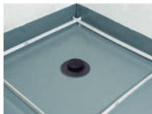
06. Poser le support de grille afin de protéger l'intérieur du siphon de sol et préparer une forme de pente vers la bonde (1cm/m). S'aider du gabarit d'aide à la chape Isotanche.
