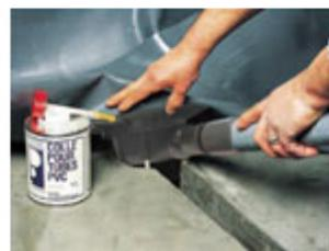
03. Orienter le siphon de sol dans le sens désiré et relier au tube d'évacuation préalablement découpé avec le solvant PVC pour soudure à froid. Régler la hauteur de la bonde à l'aide des pieds.
