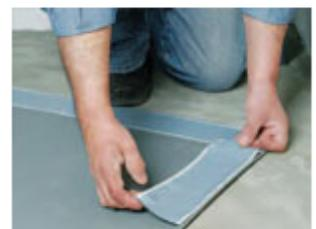
04. Ajuster la feuille Isotanche. Les remontées verticales des murs doivent être de 15/20 cm environ. Couper l'excédent des hauteurs mais ne jamais couper dans les angles. Pour fixer les remontées verticales sur les murs, coller la feuille Isotanche en utilisant de préférence la colle spéciale pour remontées Isotanche ou l'adhésif double face pour remontées Isotanche.
